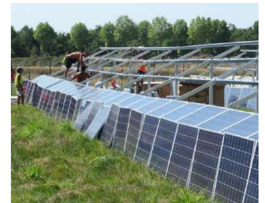
Pose manuelle des modules -
