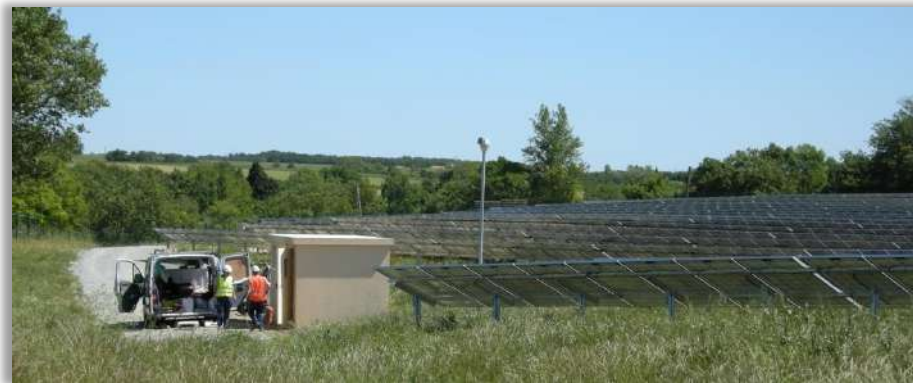
Opération de maintenance
