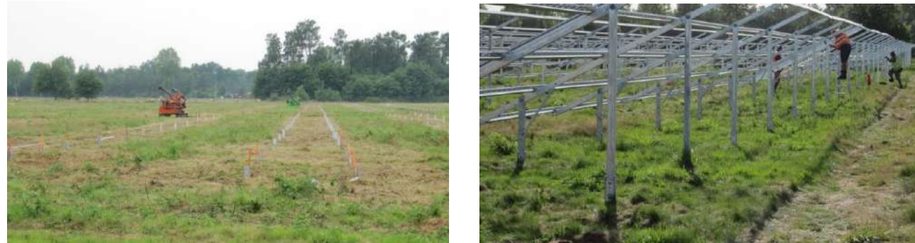
Un faible impact sur le sol et le couvert végétal lors de l'ancrage des pieux et pose de structures
