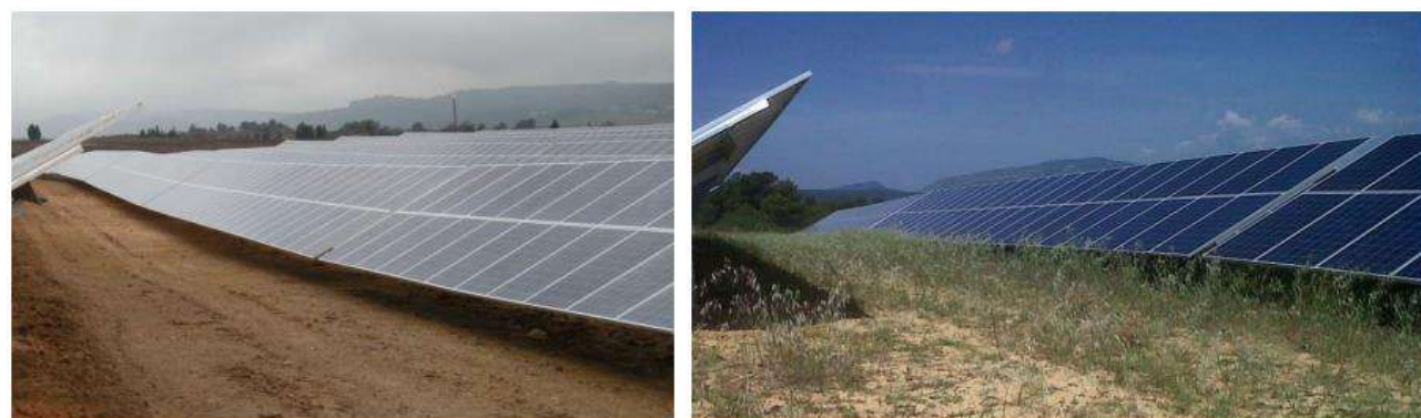
Régénération spontanée de la végétation après travaux
