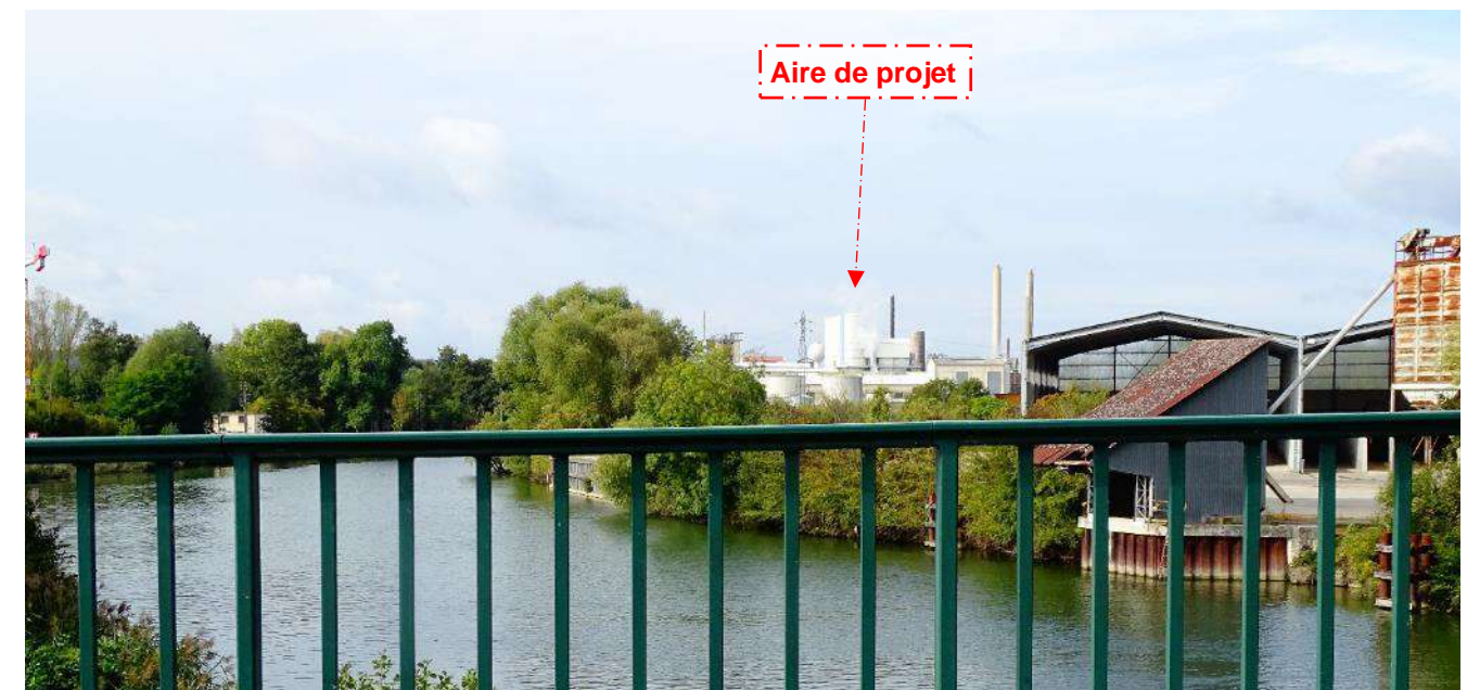
Photographie n° 29 : Pont de l'Aisne sur la RD335 (1.2 km à l'est de l'aire de projet : absence de covisibilité).
