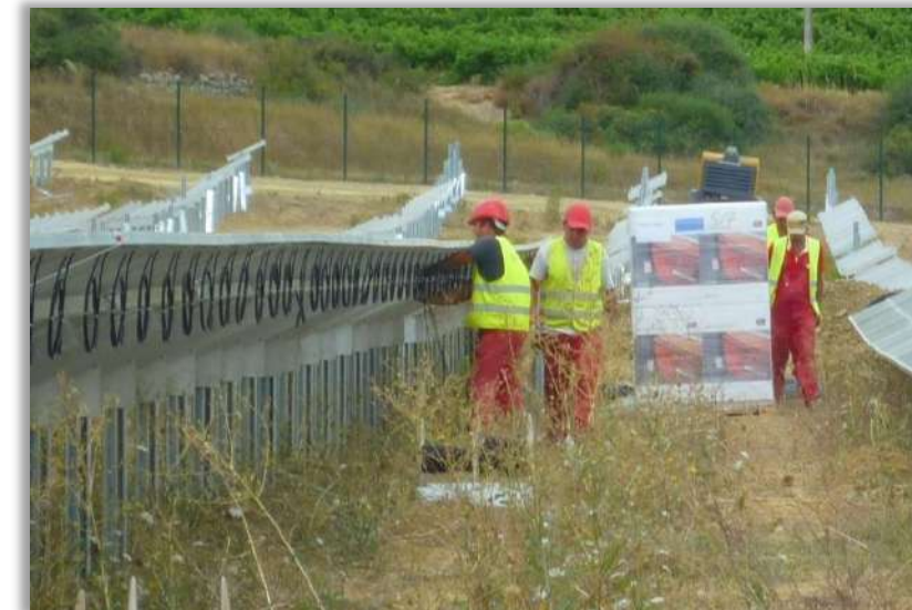
Câblage et interconnexion des modules photovoltaïques
