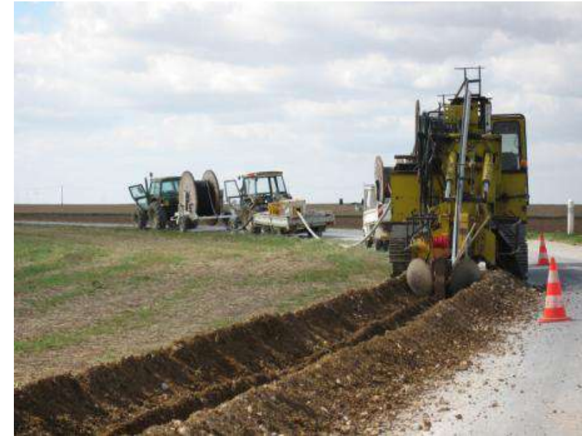
Illustration des travaux de raccordement réalisés par ENEDIS
