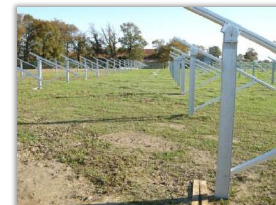
Structures prêtes à recevoir des modules
