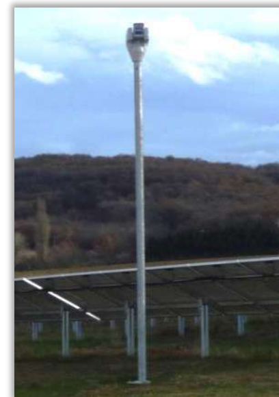
Mât de surveillance
