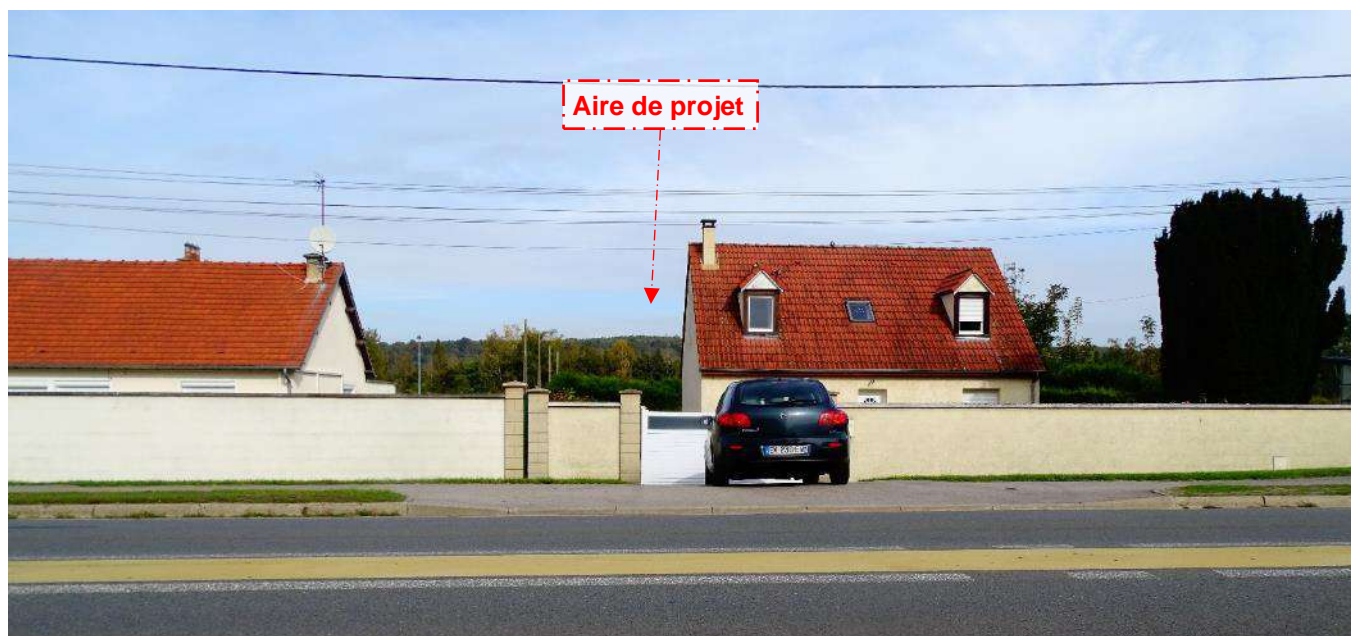
Photographie n° 31 : RN31 (1.1 km au sud-ouest de l'aire de projet : absence de covisibilité).
