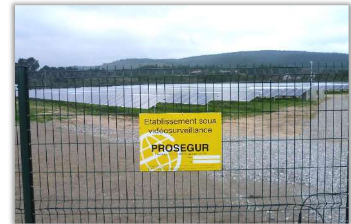
Signalétique de sécurité sur la clôture
