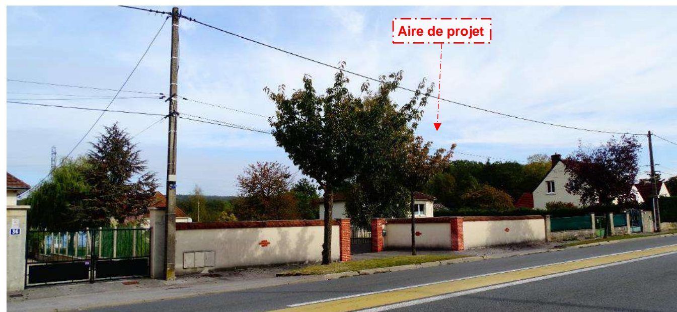
Photographie n° 32 : RN31 (1.2 km au sud-ouest de l'aire de projet : absence de covisibilité).
